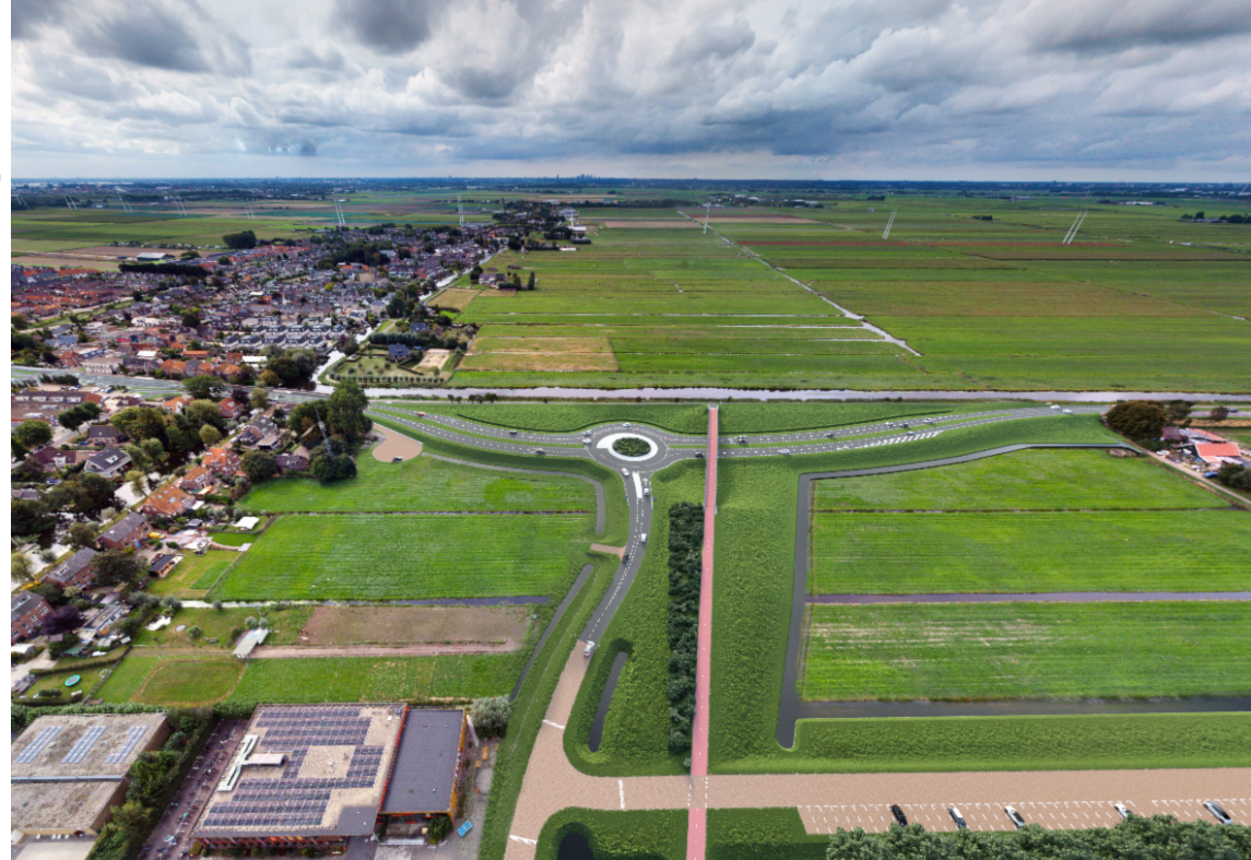
Bovenaanzicht rotonde noord en fietsviaduct Hazerswoude-Dorp
