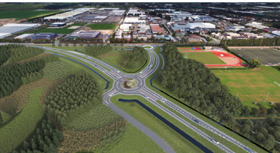
Rotondes sluiten aan op de Hoogeveenseweg
